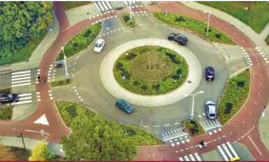
EXEMPLE D'UNA ROTONDA HOLANDESA QUE REFORÇA LA SEGURETAT DELS CICLISTES (WWW.AD.NL ANP)
